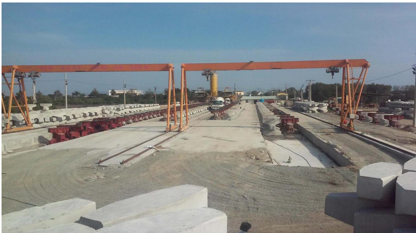
XƯỞNG ĐÚC CẤU KIỆN BÊ TÔNG (STRUCTURAL FOUNDRY)
