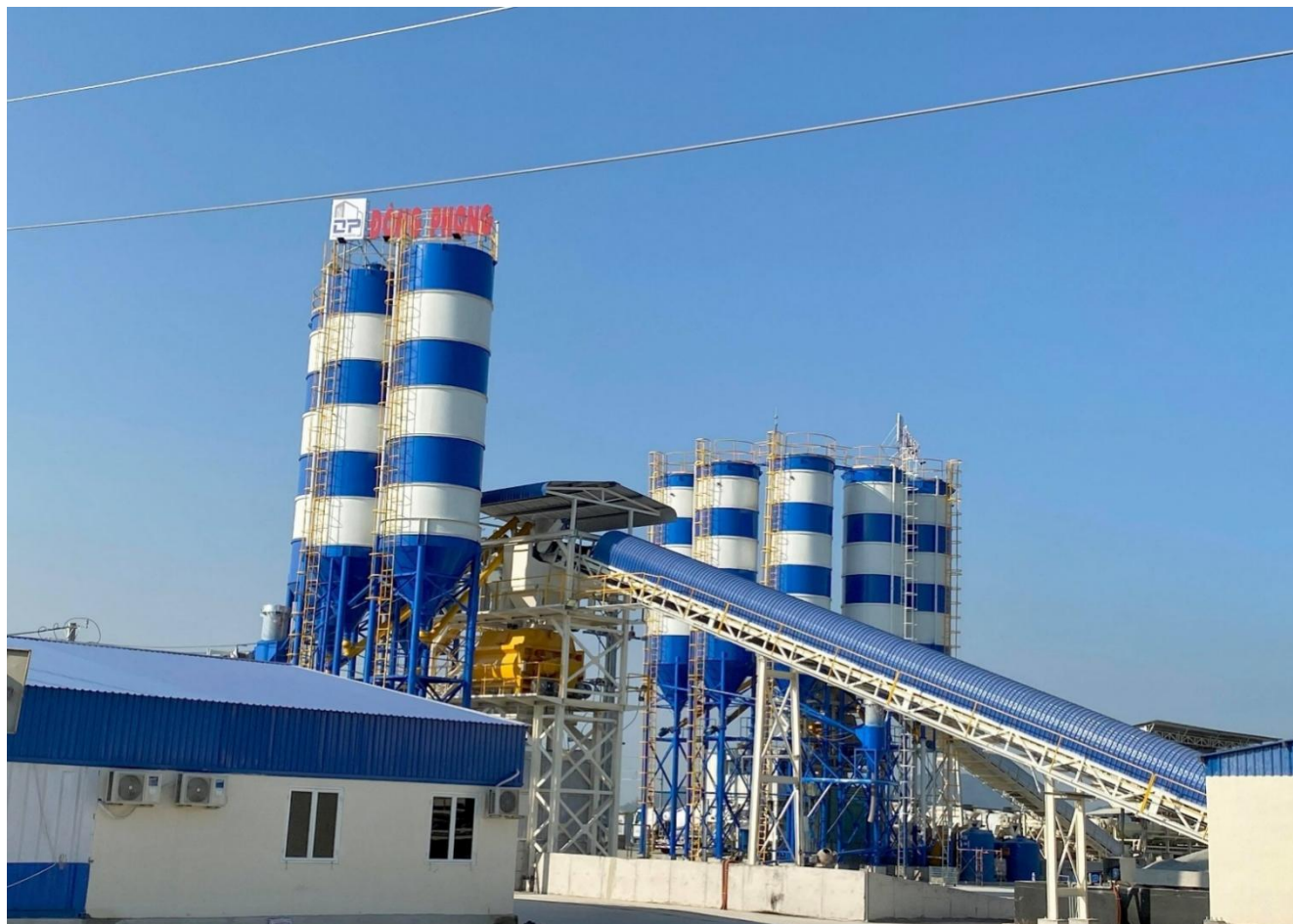
TRẠM BÊ TÔNG THƯỜNG PHẨM 120M 3 /H (CONCRETE PLANT 120M 3 /H)
